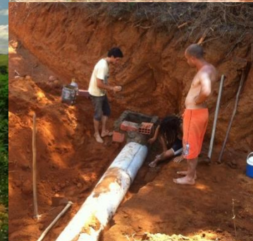
Superior: Mistura de barro / Inferior: Obra de Acessibilidade
